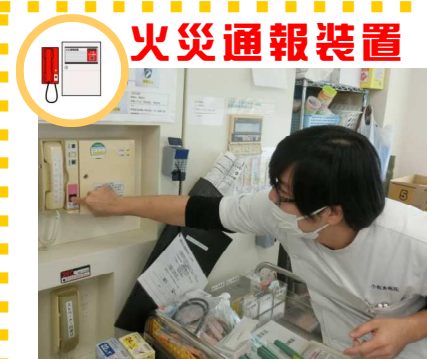
火災通報装置 ボタンを長押しすると自動的に119番に電話がかかります！
